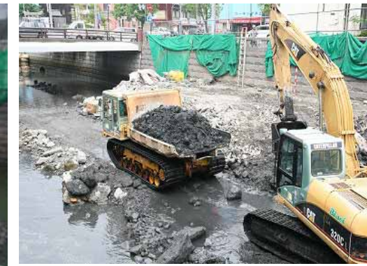
攪拌30分後積み込み運搬処理
