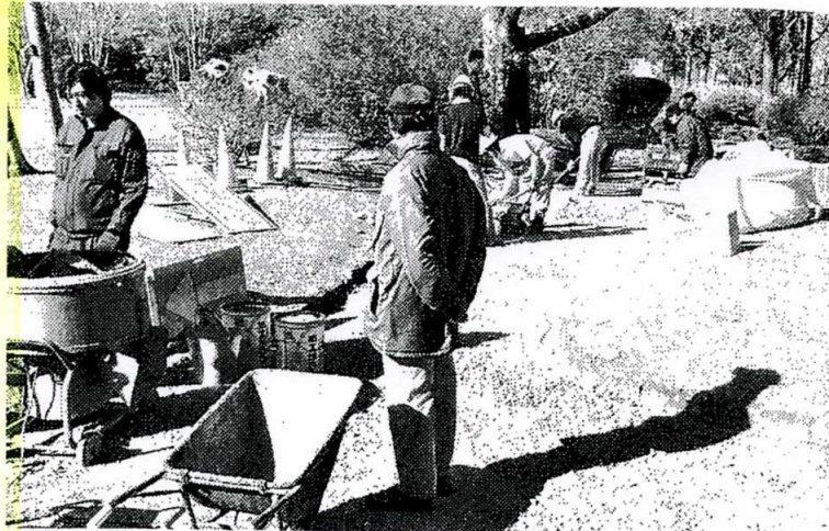
「木チップ舗装材」試験施工の状況
