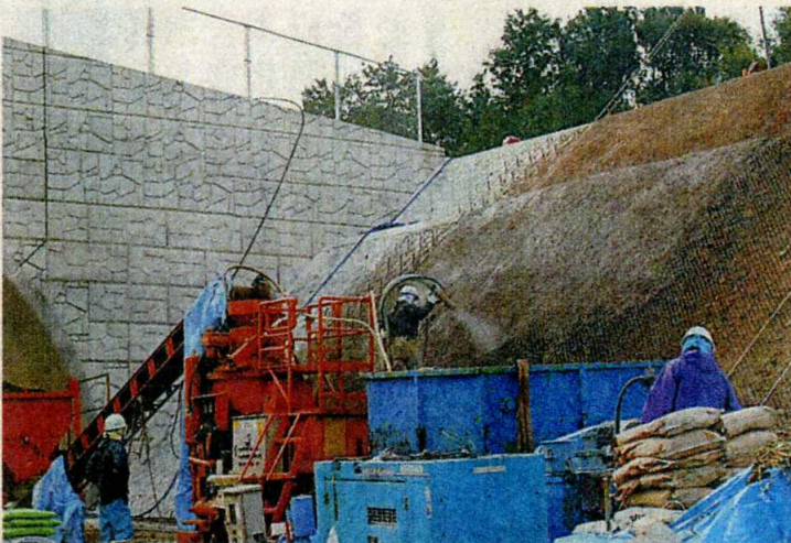
廃木材を利用した緑化基盤材をのり面に吹き付けた試験施工現場 = 東彼杵町
